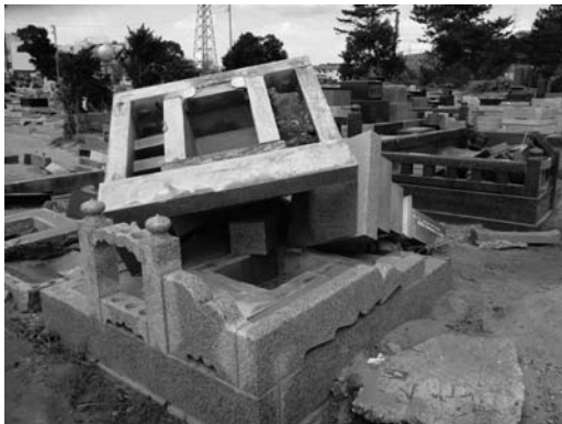
福島県いわき市内にある沿岸部の墓地では、津波により、さお石から芝台まで一体となったまま倒れたお墓もあった（2011年3月27日、編集部撮影）
