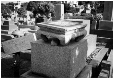
地震対策はほとんど取られていなかった (阪神淡路大震災にて)
