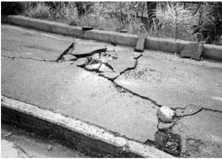
阪神淡路大震災で大きな被害が出た霊園
