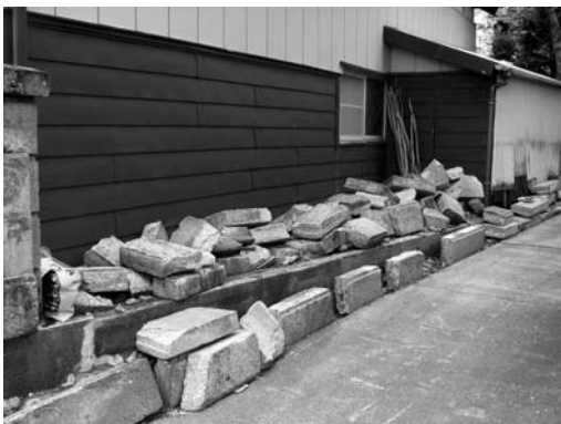
無鉄筋の石塀が崩落したため、とりあえず道路脇に寄せられた(牧之原市、写真:同社提供)
