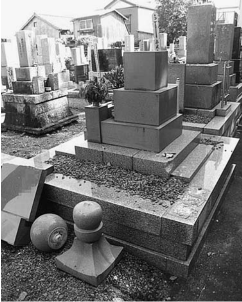
水輪にダボを付けた五輪塔も、墓誌と共に無残に転倒している（藤枝市・共同墓地）
