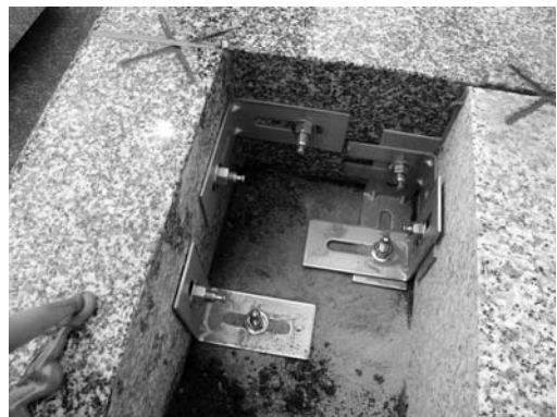
同社の本施工で、外柵の内部に頑丈に取り付けられたL字金具。合端上部にも十字金具が埋め込まれている(写真:同社提供)
