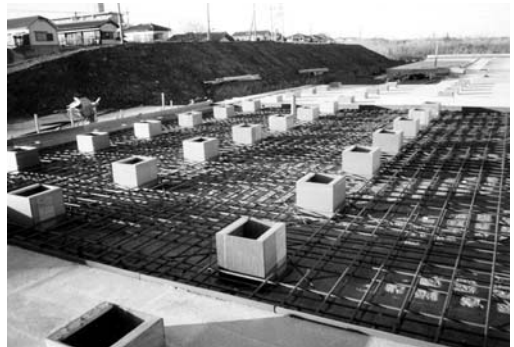
耐圧盤による入念な基礎工事が行われた光明寺墓苑
